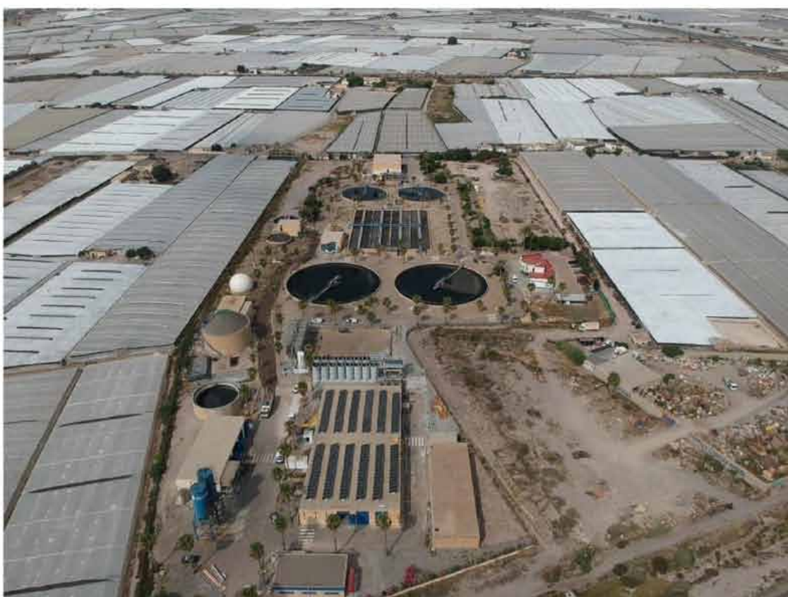
Depuradora de Roquetas con sistema terciarioHidralia
