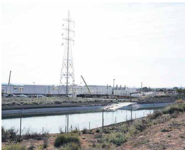
Un depósito de agua junto al centro de datos de El Burgo de Ebro, cuya primera fase sigue en obras.
